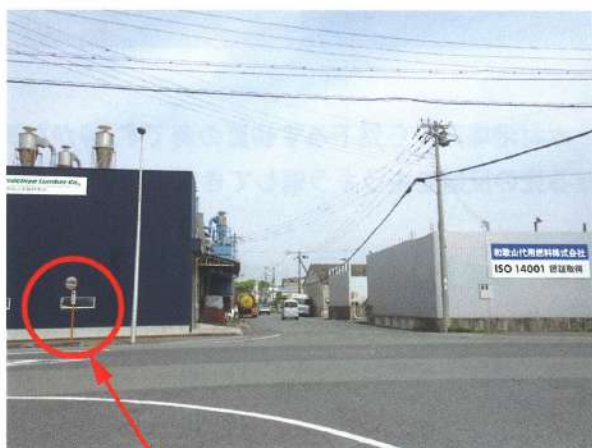
カーブミラー設置
