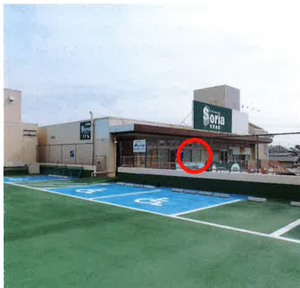
2F 駐車場から
