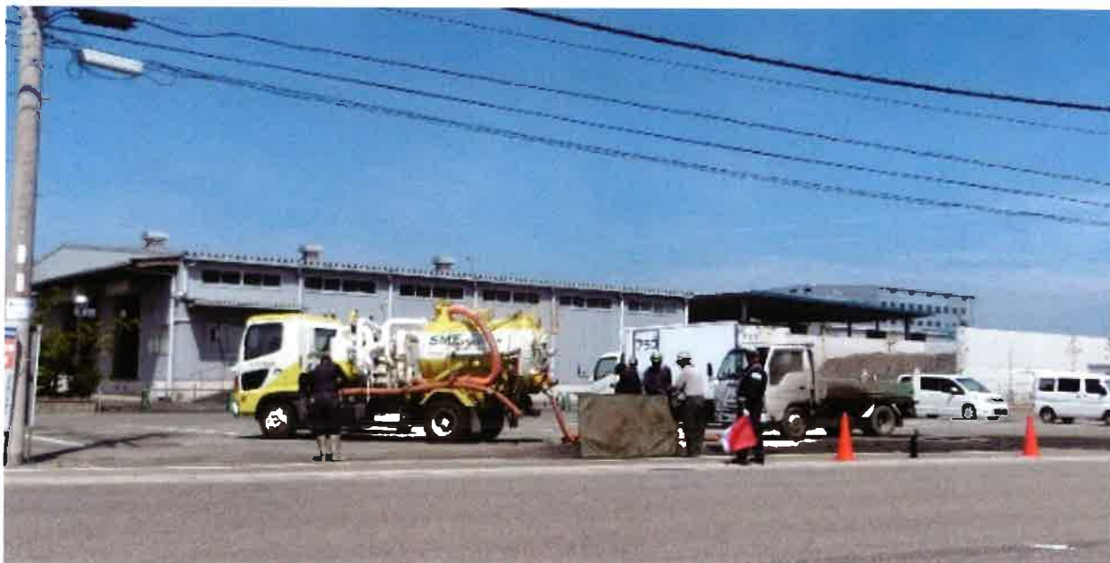
ローソン前の清掃状況
