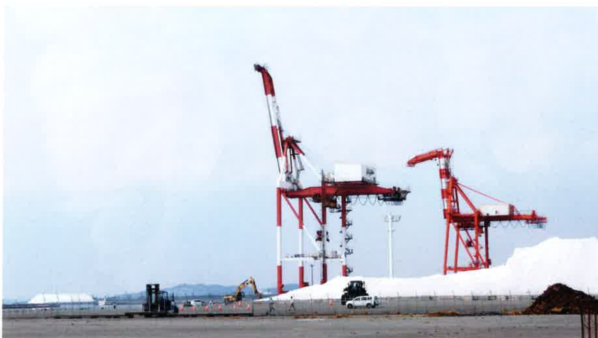
ガントリークレーン
